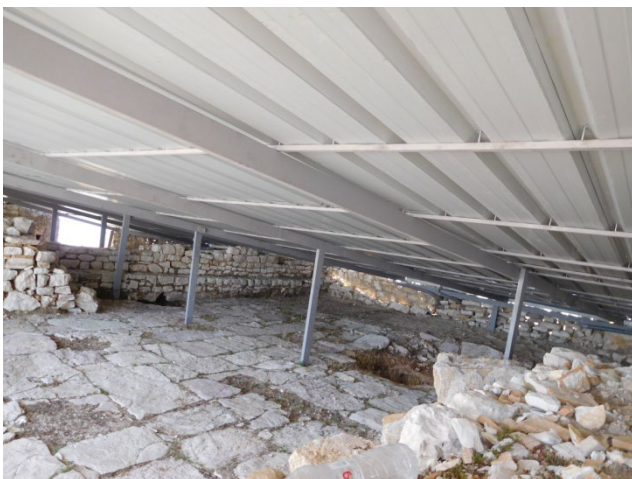
11. Pamje e brendshme e konstruksionit metalik
